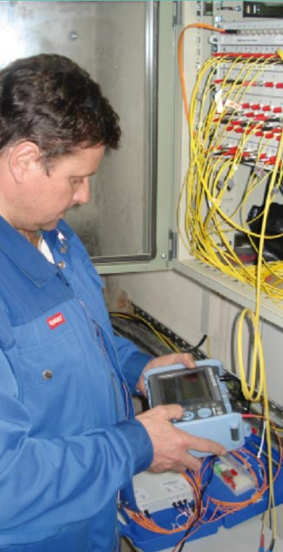
Die Techniker überprüfen teilweise mehrere hundert Fasern pro Tag. Dabei müssen Probleme bei der Installation oder Entstörung schnell erkannt und lokalisiert werden können.
