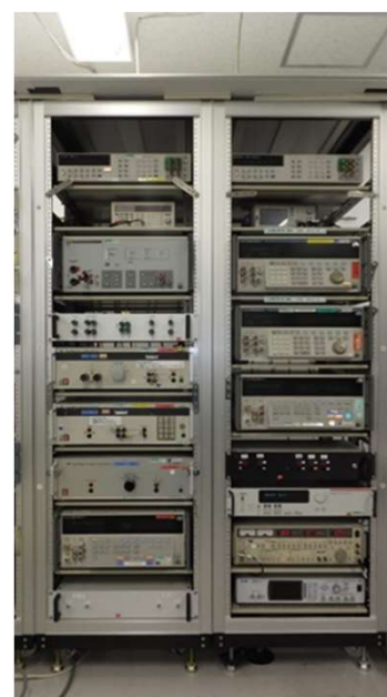
図4 新電力校正システム外観
